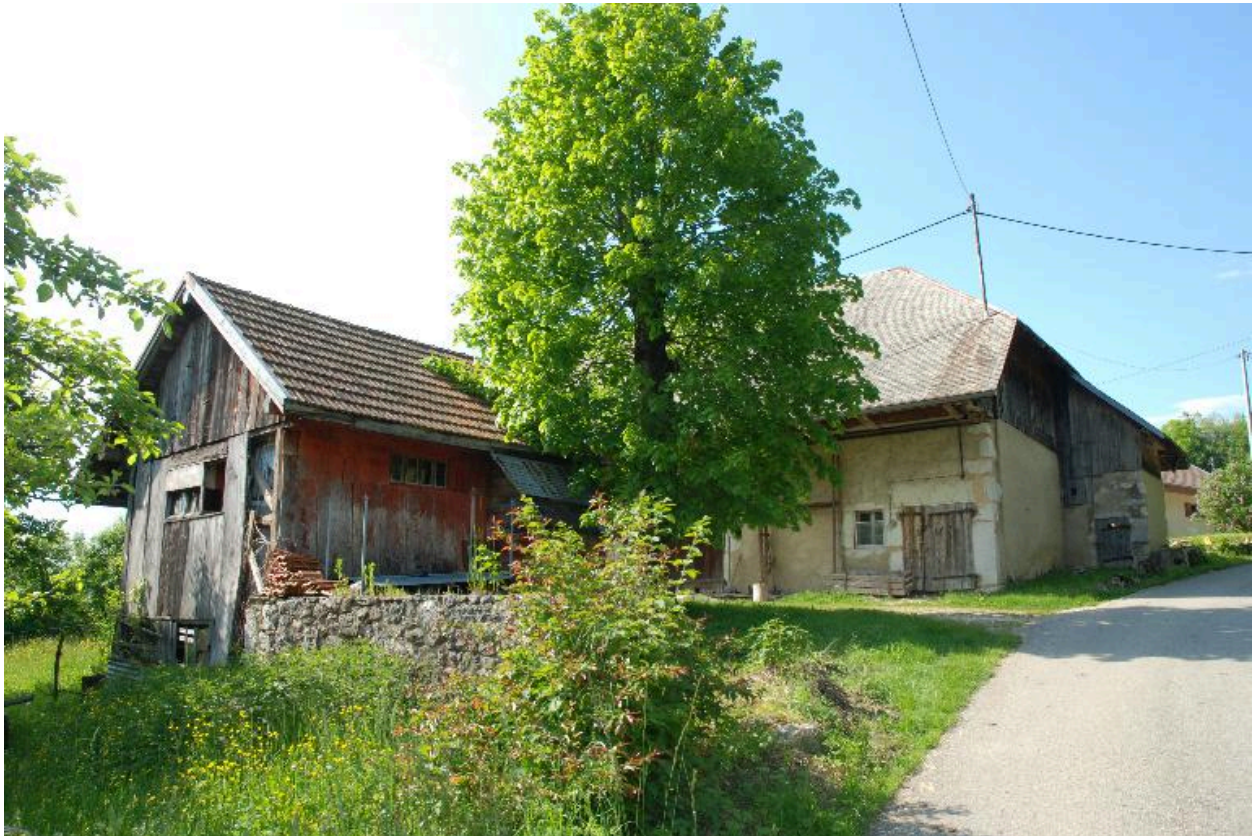
Vue générale depuis le sud-est. Au premier plan, remise en charpente.
