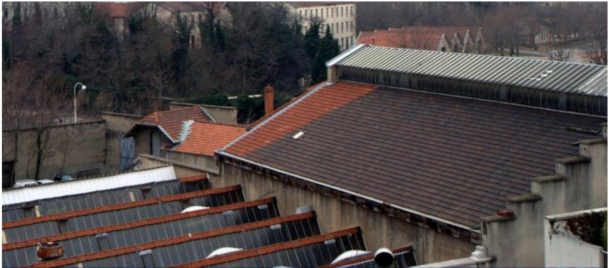
Atelier : détail des toitures
