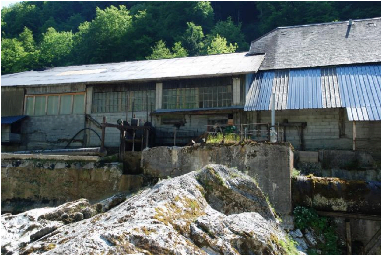
Vue de la partie centrale de la scierie depuis l'est.
