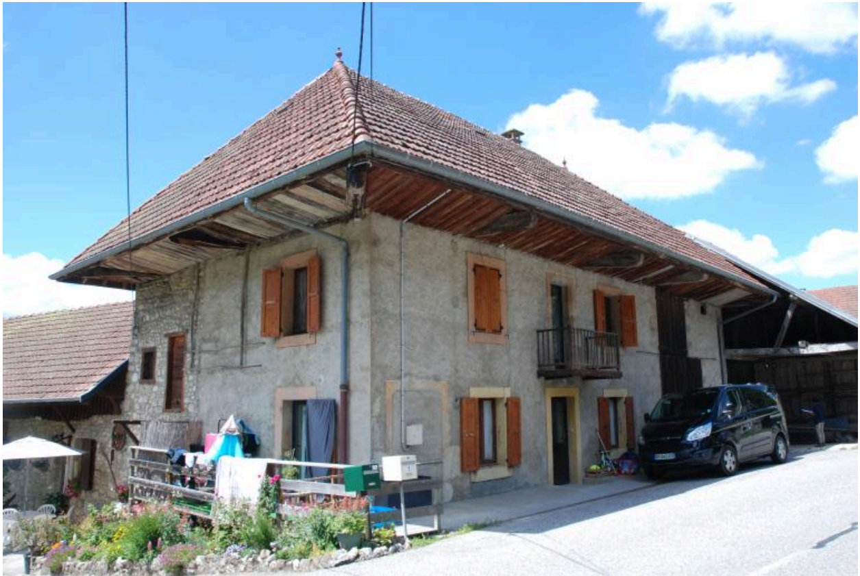
Vue de la ferme située à l'emplacement de la maison des Blanli, élévations sud et est.
