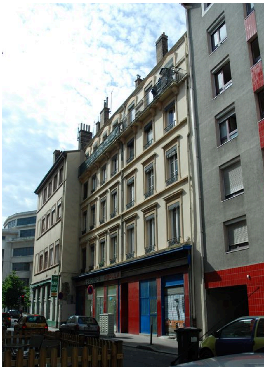
Vue générale, élévation sur rue
