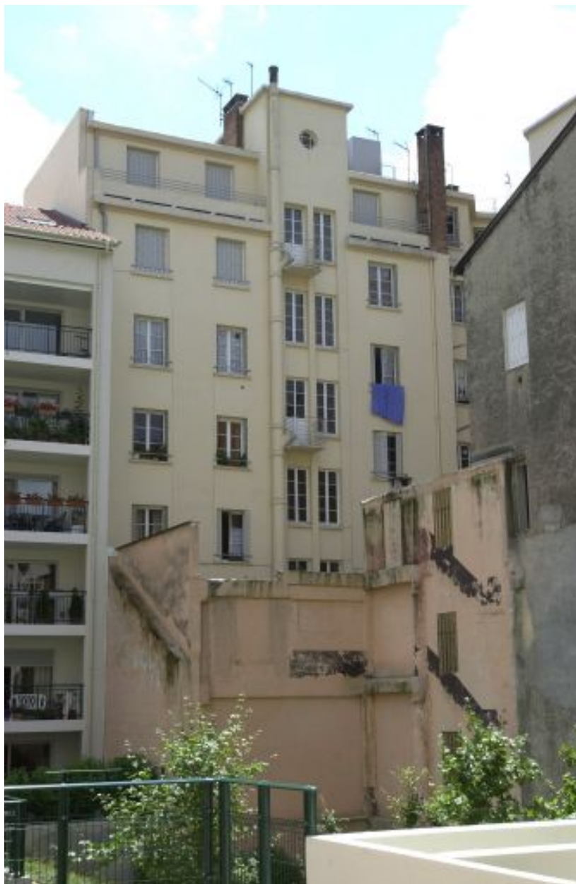
Elévation postérieure du 54 rue Smith
