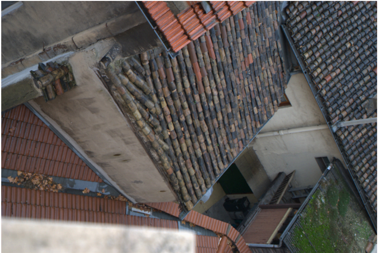
Élévation postérieure, cour et corps de bâtiment en retour
