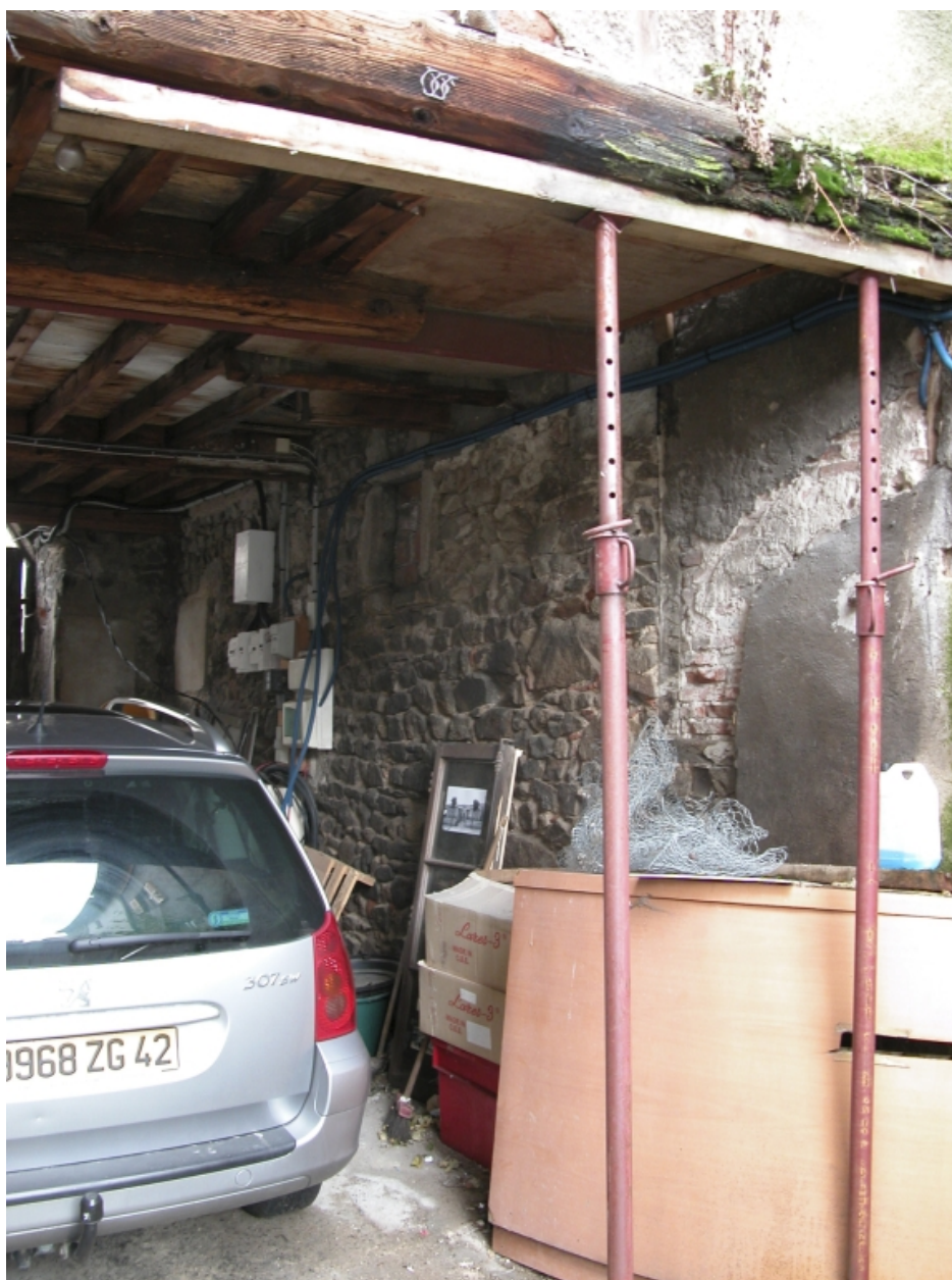
Îlot 2. Roanne (rue de) 13, 15. Détail du mur latérale droit sur cour de la maison.
