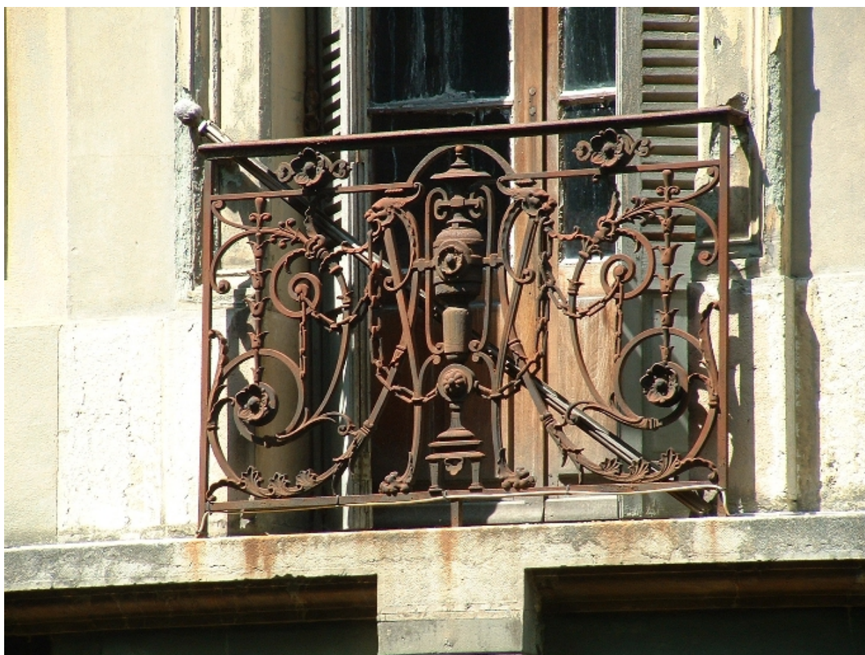
Détail d'un garde-corps
