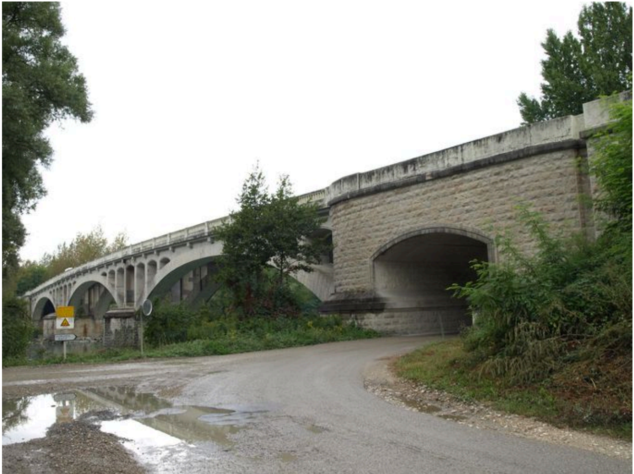
Arches et culée passante, rive droite
