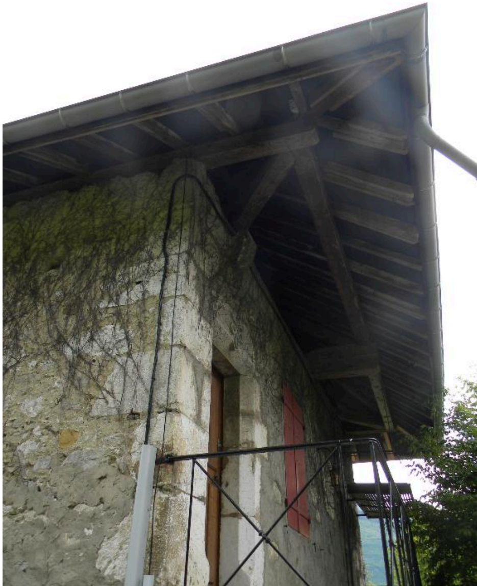
Vue de la charpente du débord de toit.
