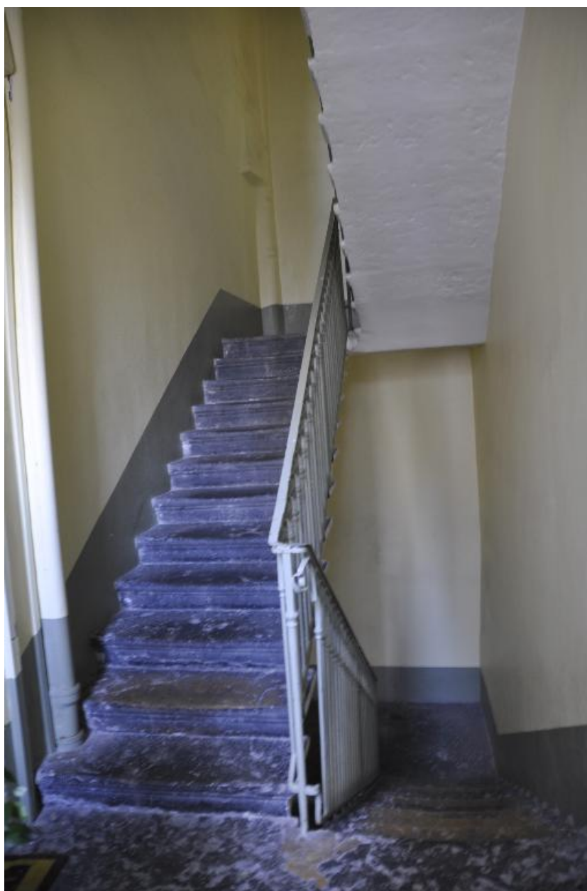
Vue de l'escalier depuis le palier
