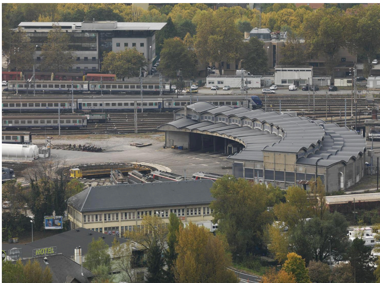
Rotonde de Chambéry, entrepôt
