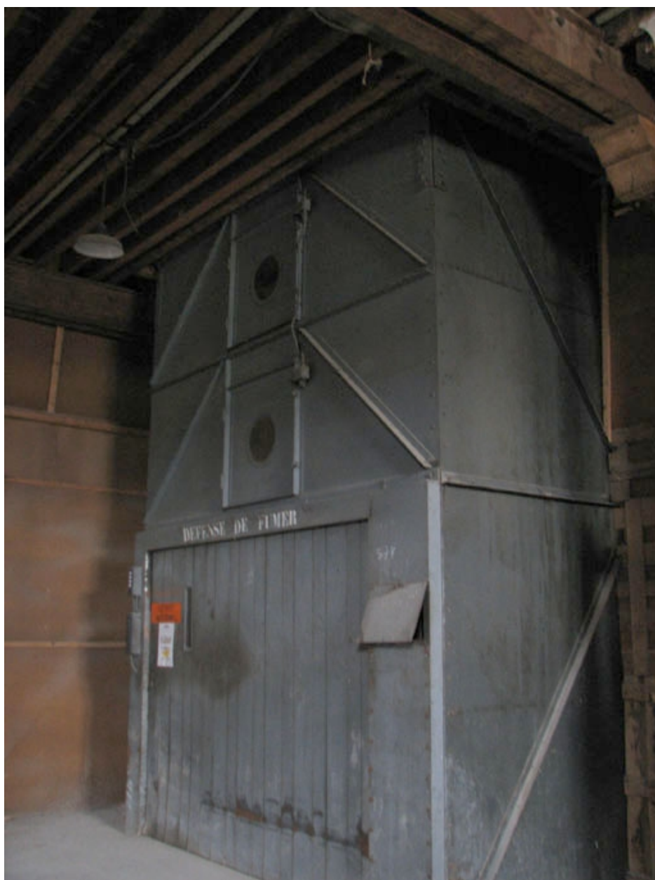
Monte-charge aile nord partie nord-est
