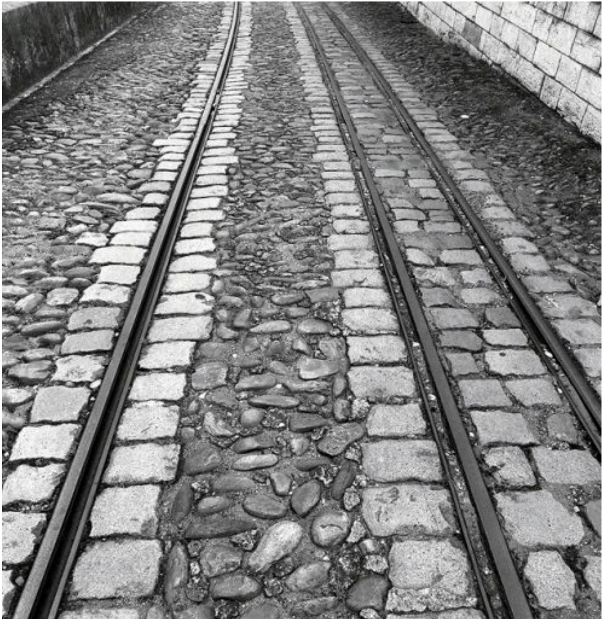
Les rails sur le bas-quai, rive gauche, à la hauteur de la place Gensoul
