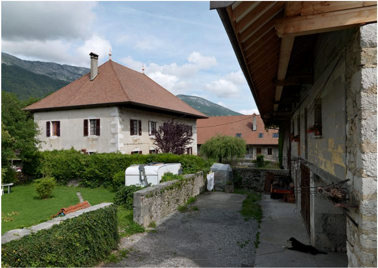
Vue d'ensemble de la ferme faisant face à ses dépendances agricoles.
