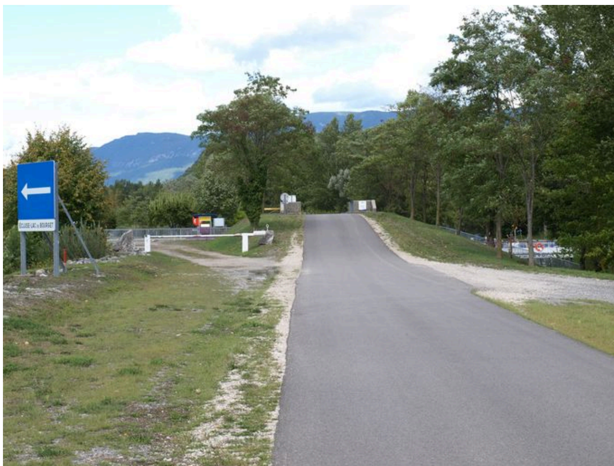
Vue générale du pont sur l'écluse
