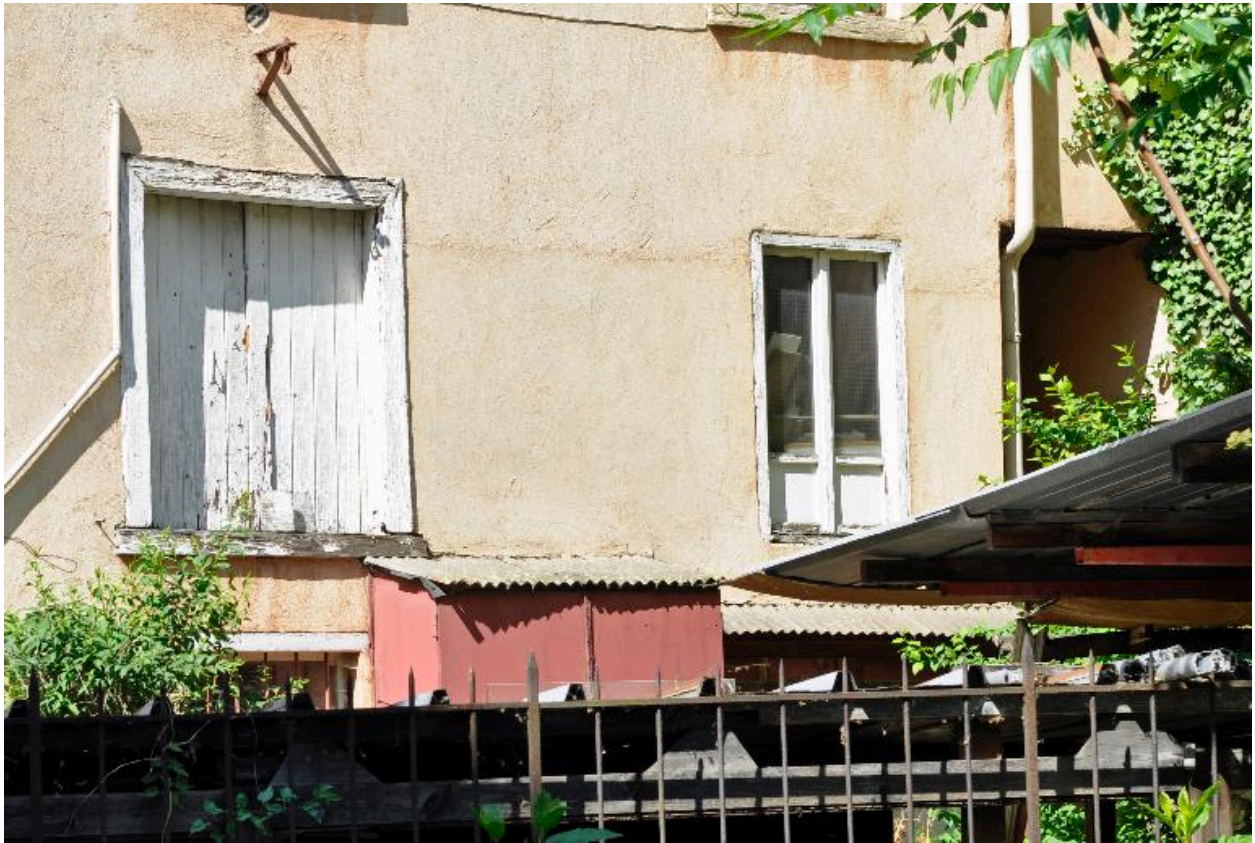
Vue partielle de l'immeuble, élévation sur cour : encadrements de fenêtres en bois
