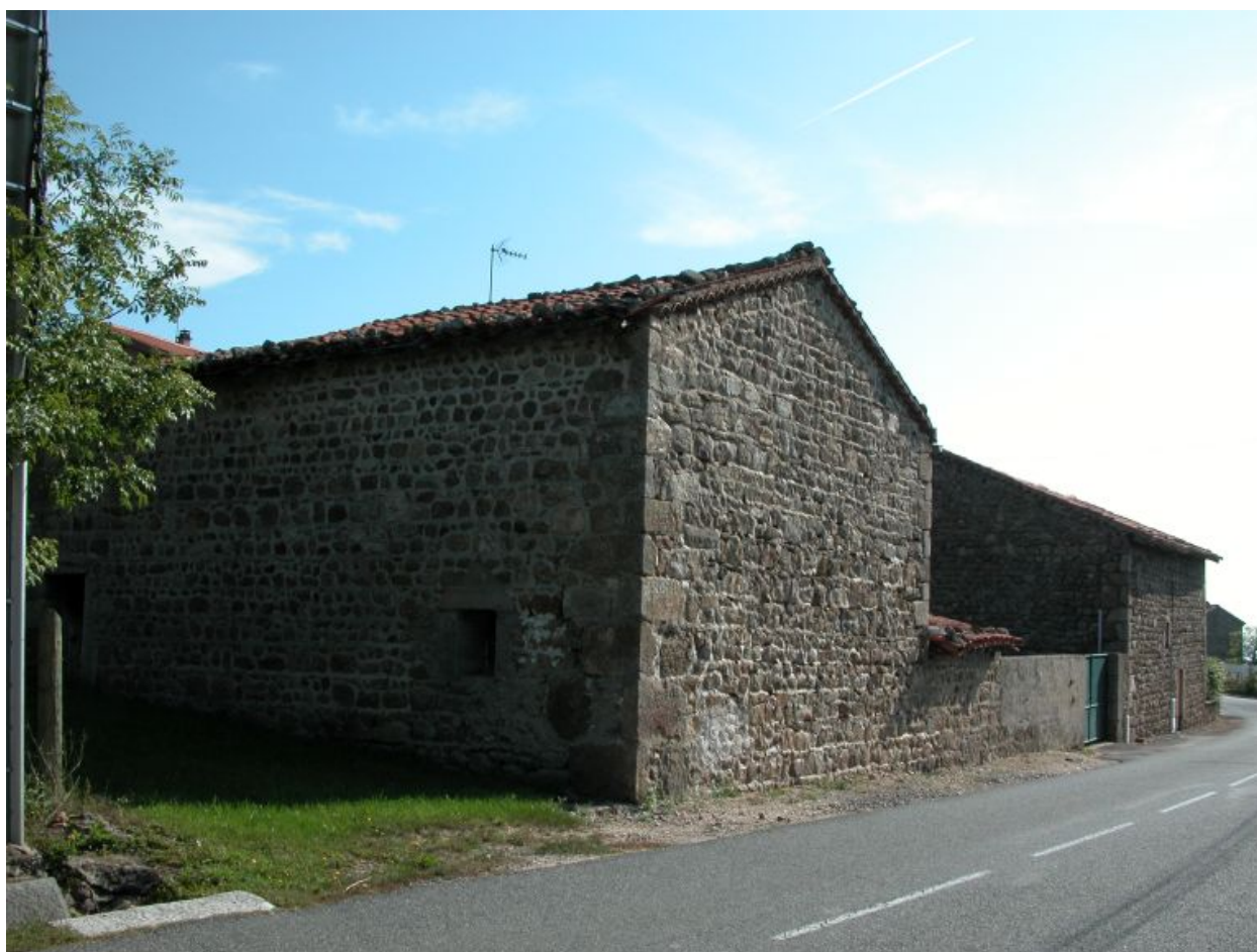
Vue d'ensemble arrière du hangar.
