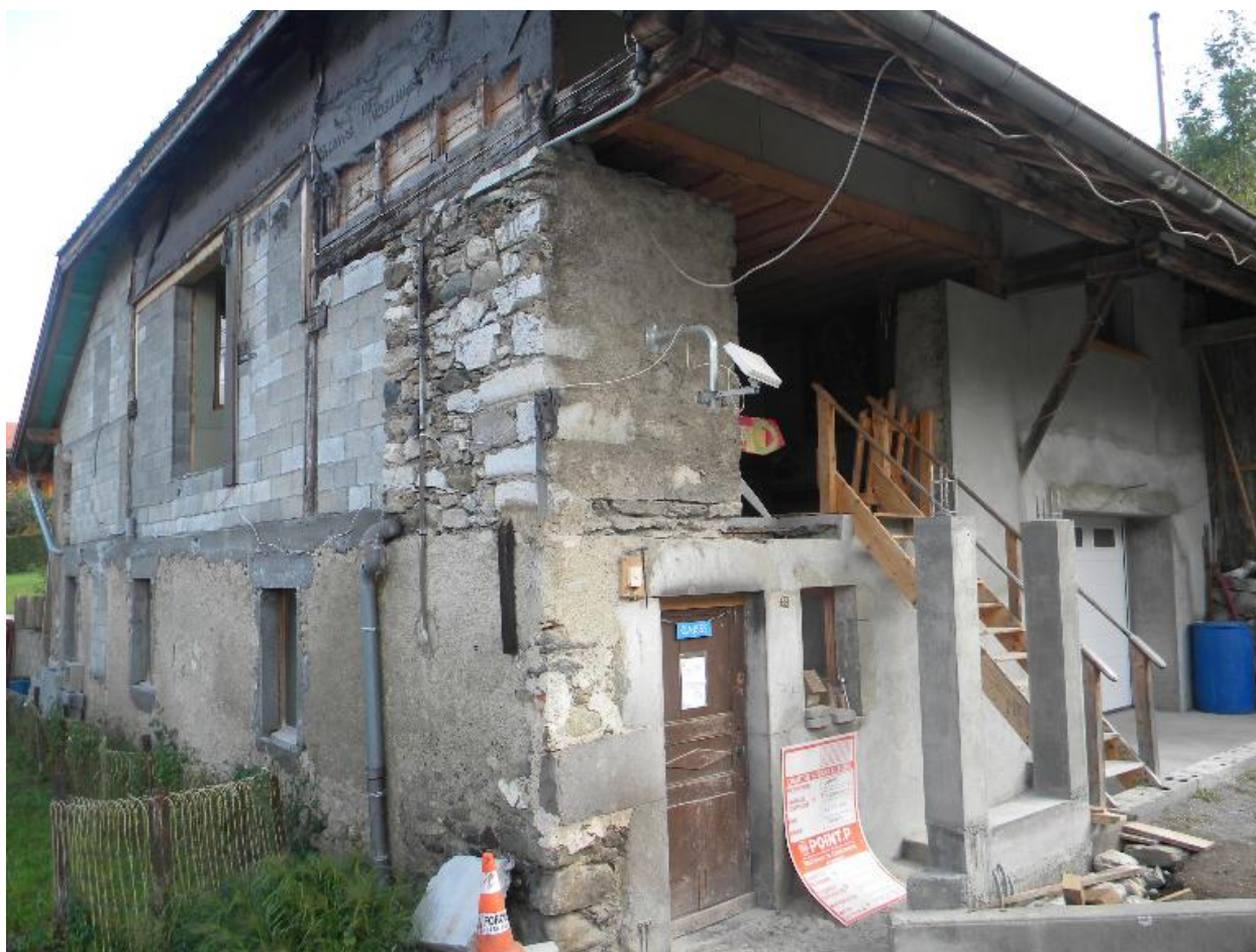
Vue d'une ancienne ferme modifiée (2008 E8 1037).
