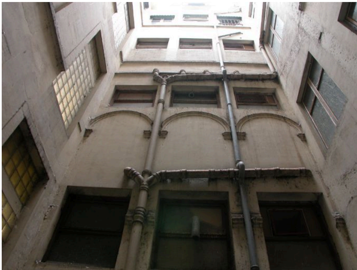
Cour, vue centrée sur l'élévation nord, à partir du 2e étage
