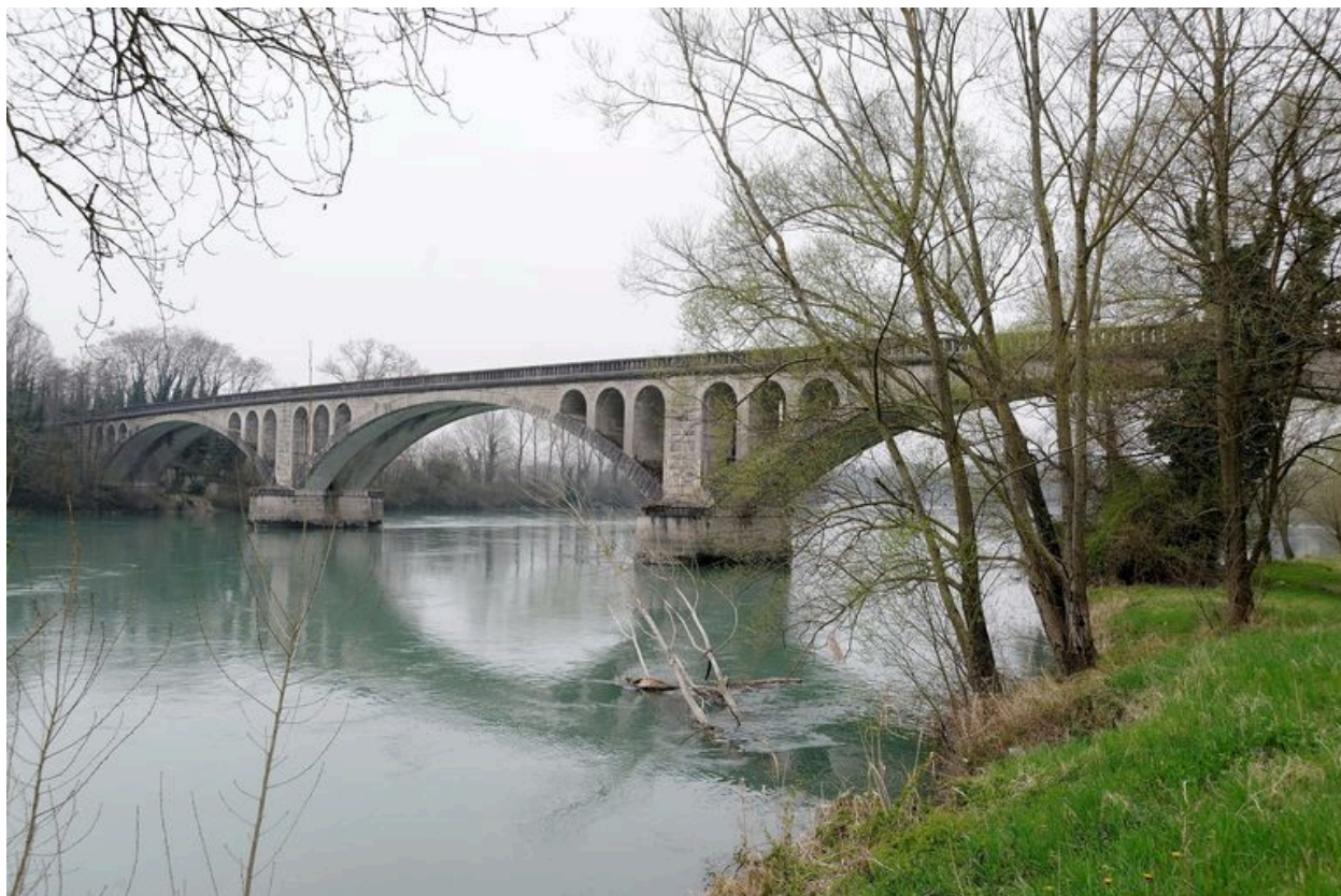
Vue côté amont, depuis la rive droite
