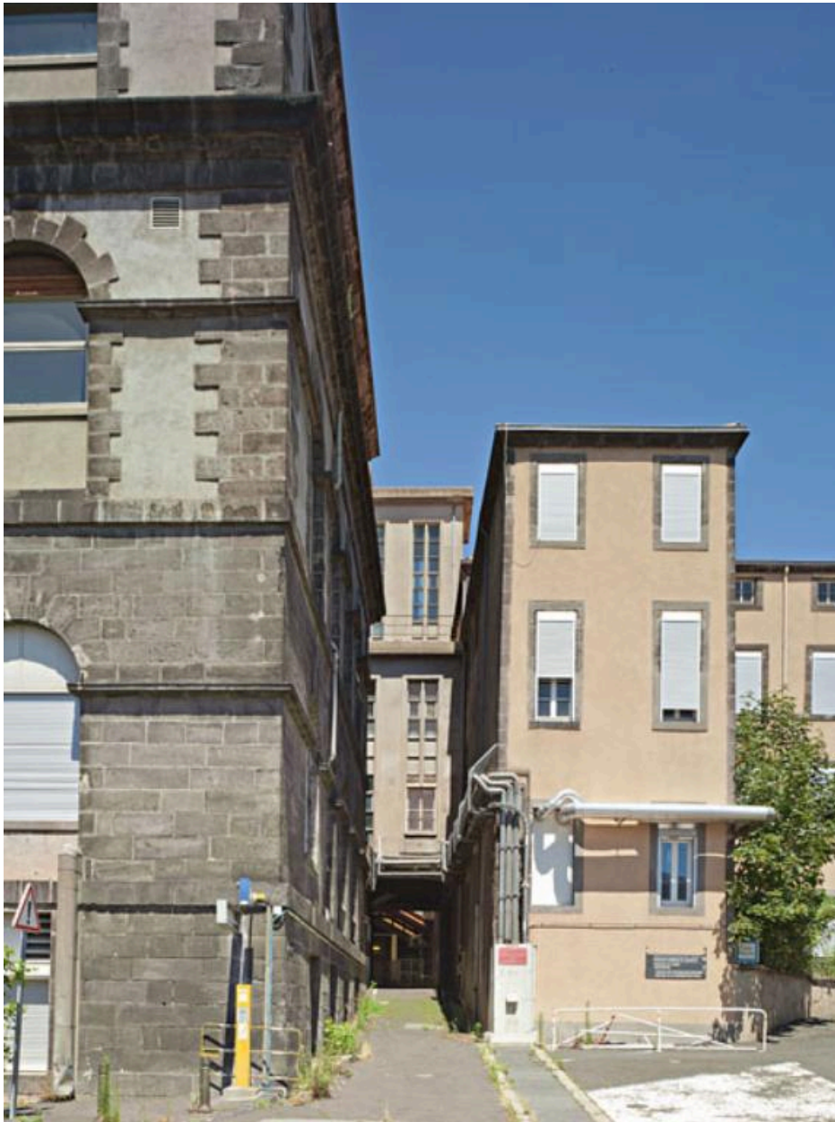
Hôtel-Dieu de Clermont-Ferrand. Le Refuge, passage entre le Refuge et le corps de bâtiment oriental de l'hôtel-Dieu (dit cour des cuisines) ; photographie prise du sud.
