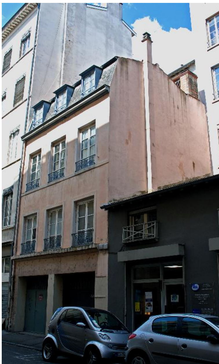
Vue d'ensemble, depuis la rue Cavenne
