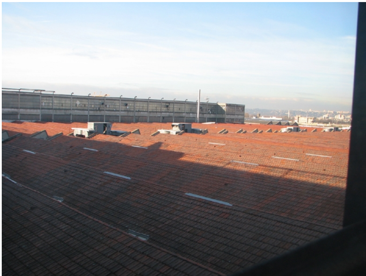
Vue d'ensemble de la toiture shed
