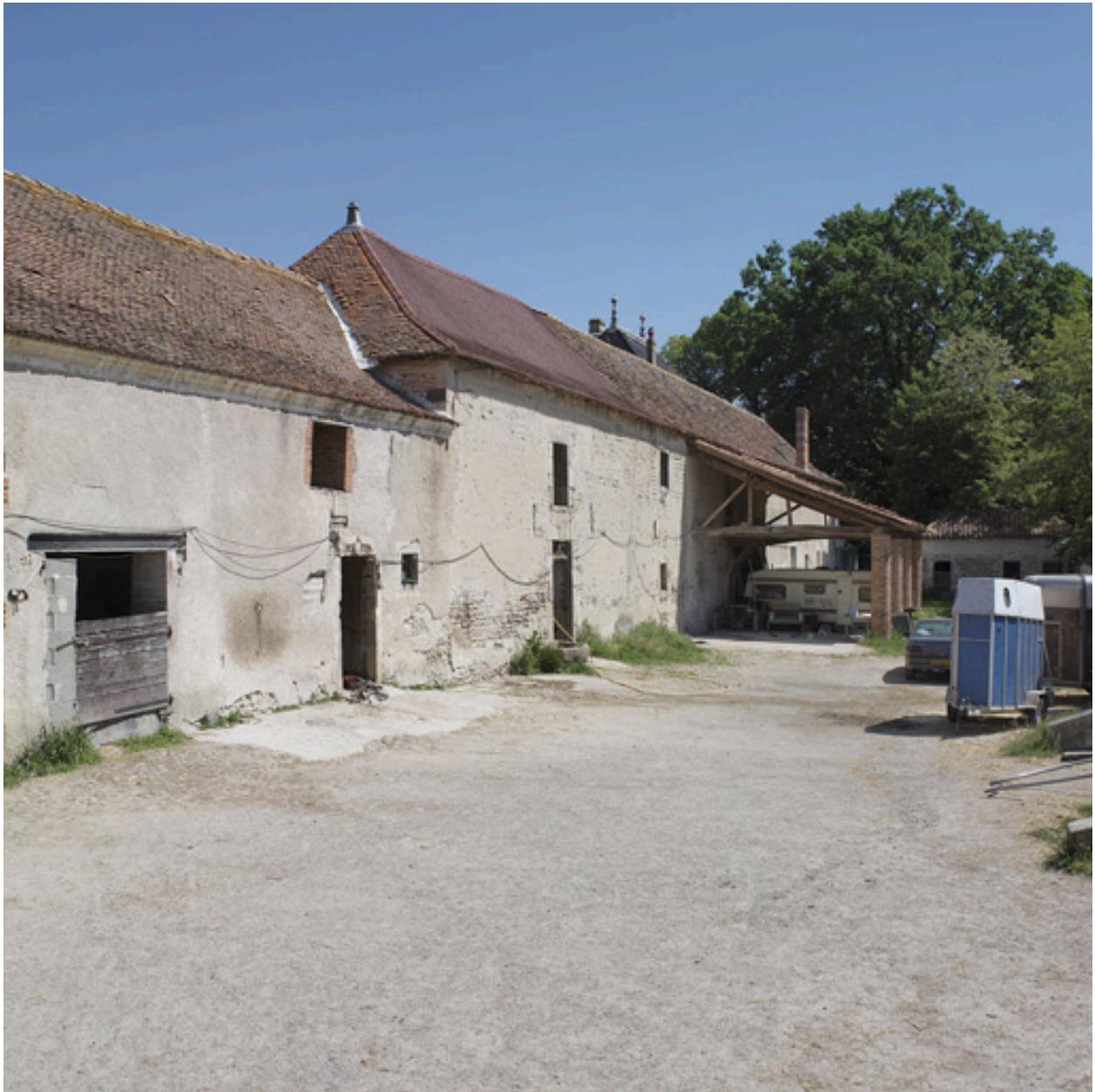
Vue de l'aile sud, élévation sud, depuis le sud-ouest (état avant travaux).
