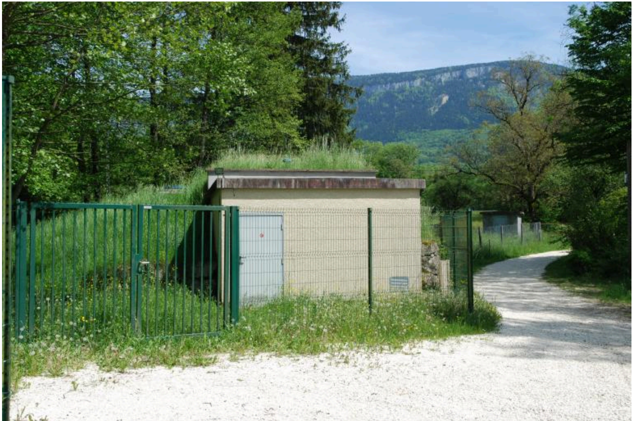
E2 1311, Monderesse (la), réservoir. Vue d'ensemble.
