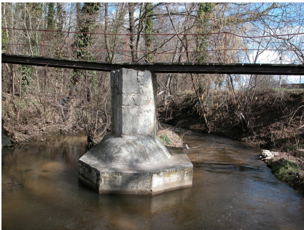
Vue de la pile centrale.
