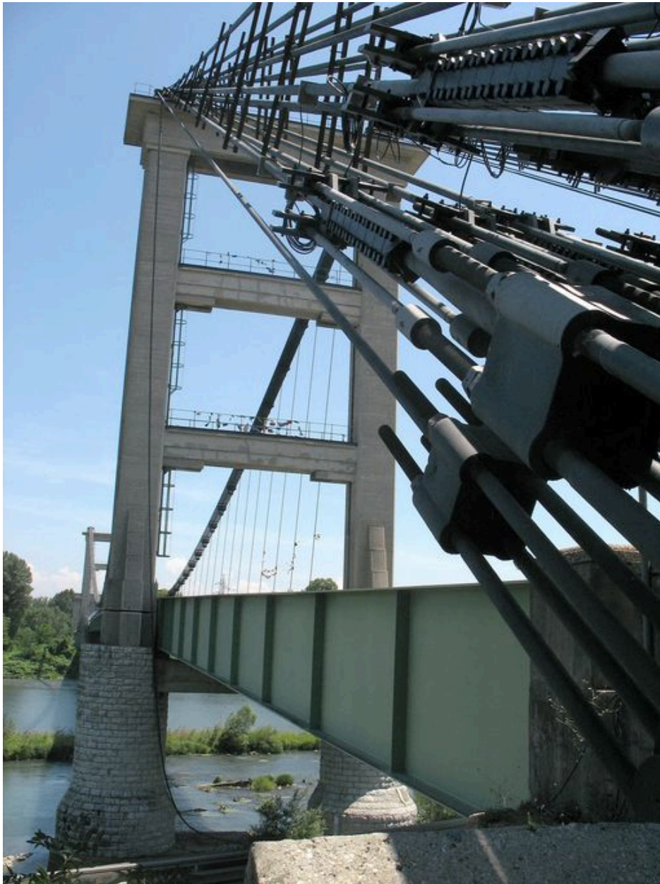
Pylône rive droite, câbles d'ancrage et vue partielle du tablier (travée de rive, côté amont)
