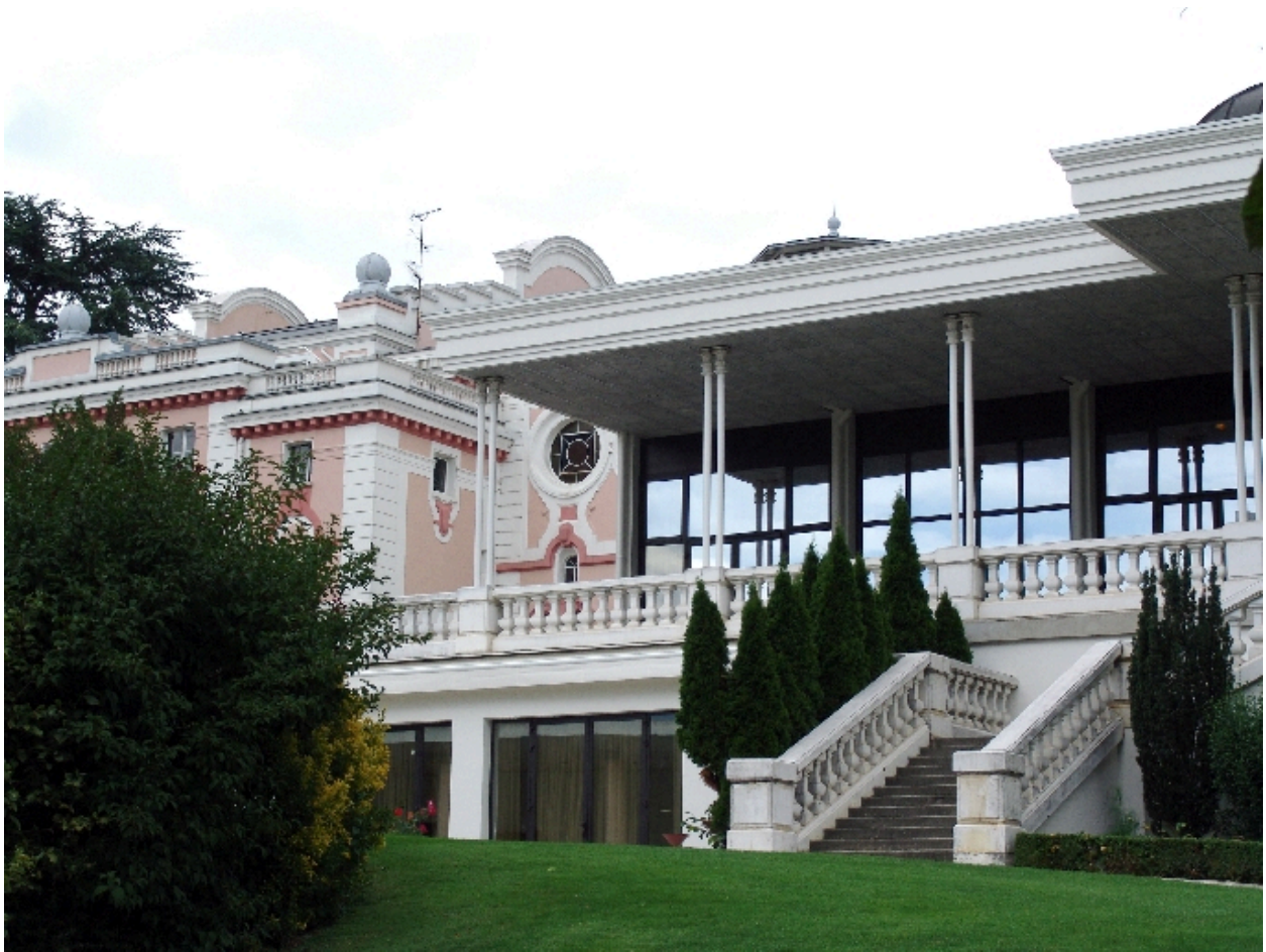
Liaison entre le théâtre et le casino à l'ouest
