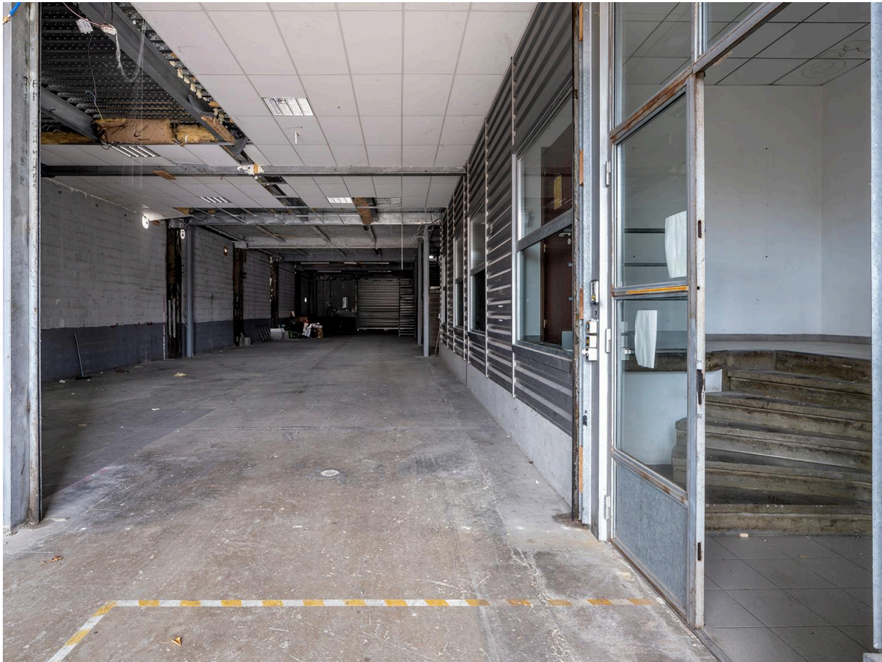
Vue intérieure avant démolition
