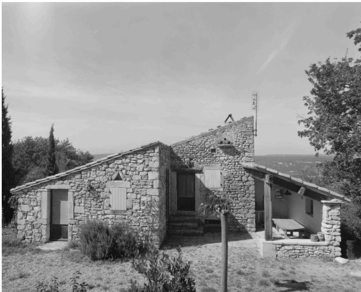
La Côte. Elévation principale de la ferme parc. D 193.
