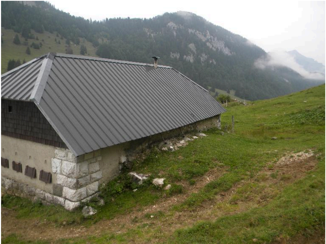
Vue de la façade arrière semi-enterrée.
