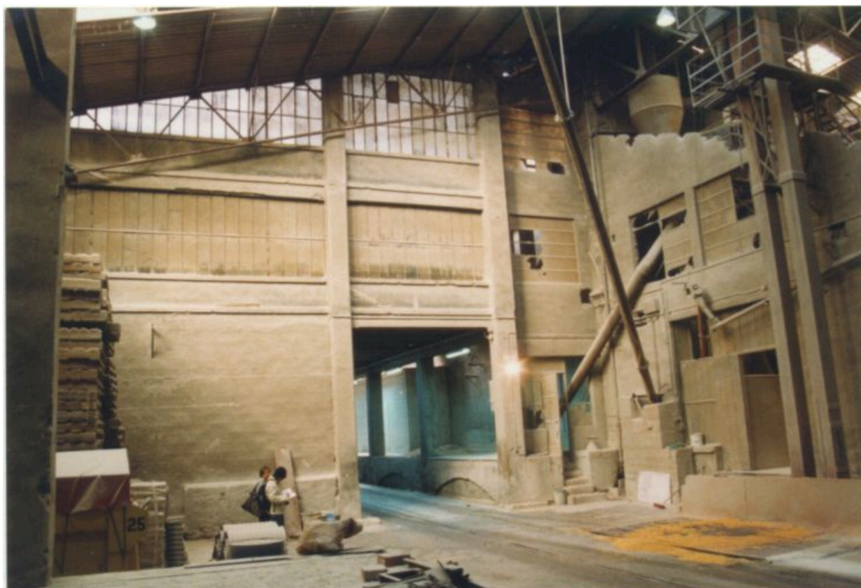
Vue intérieure, pièce en vaisseau longitudinal
