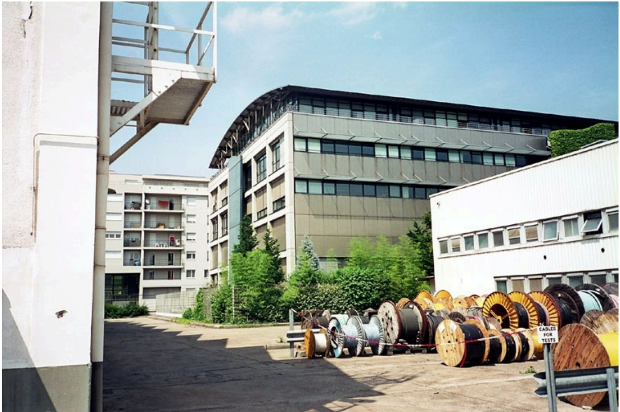
Vue d'ensemble sud
