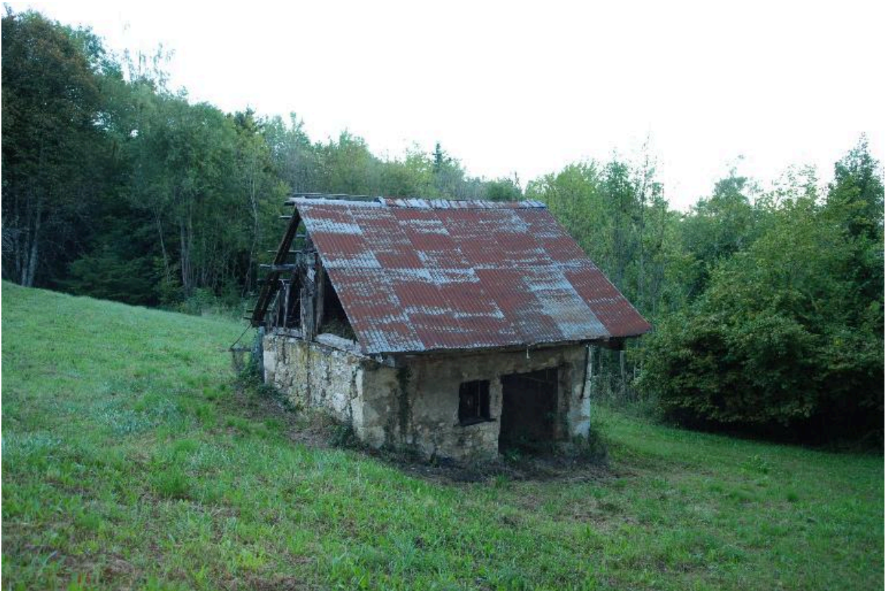
Vue d'ensemble de l'étable dans son site.
