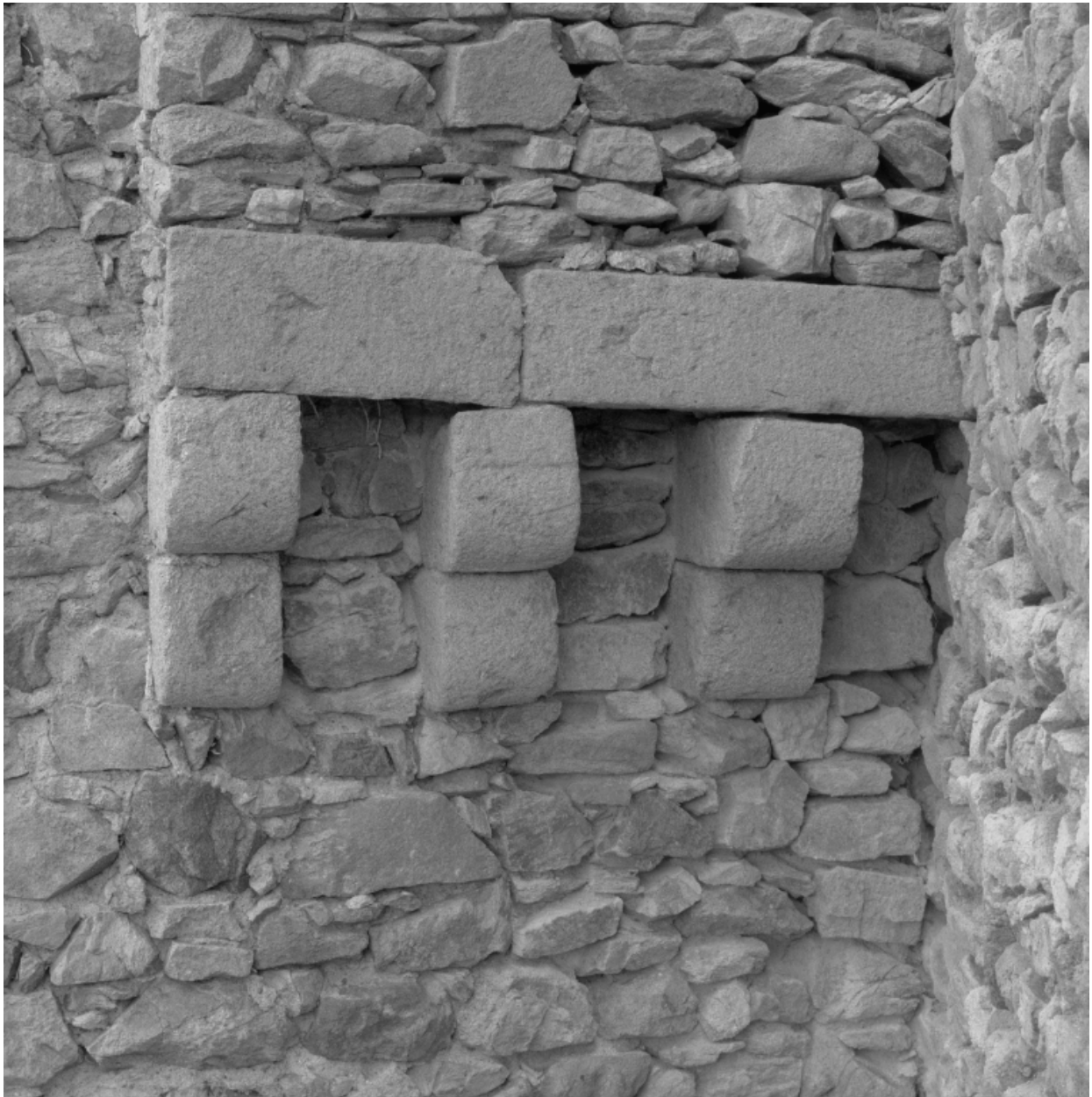
Troisième baile, château fort primitif, tour dite tour Saint-Antoine : détail de la console du conduit de la latrine du rez-de-chaussée, du sud-ouest.
