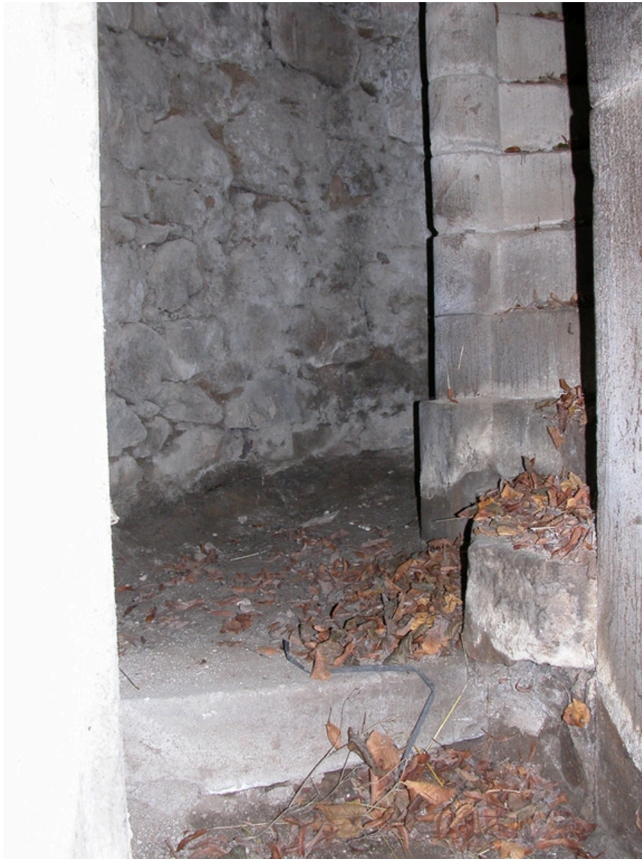
Détail du départ de l'escalier en vis nord-est.
