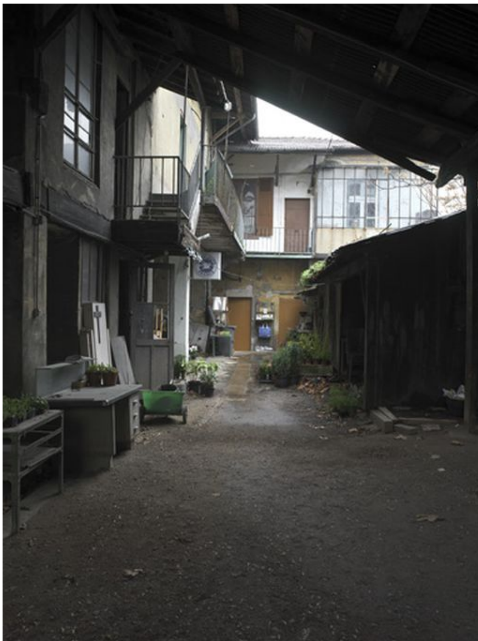
La cour (BX 22). Elévation postérieure des bâtiments est de l'avenue Berthelot et sud de la rue de l'Eternité
