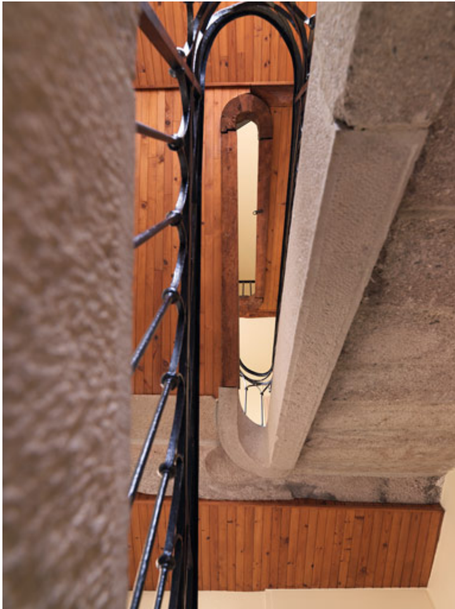
Escalier tournant à retours avec jour, vu par dessous.
