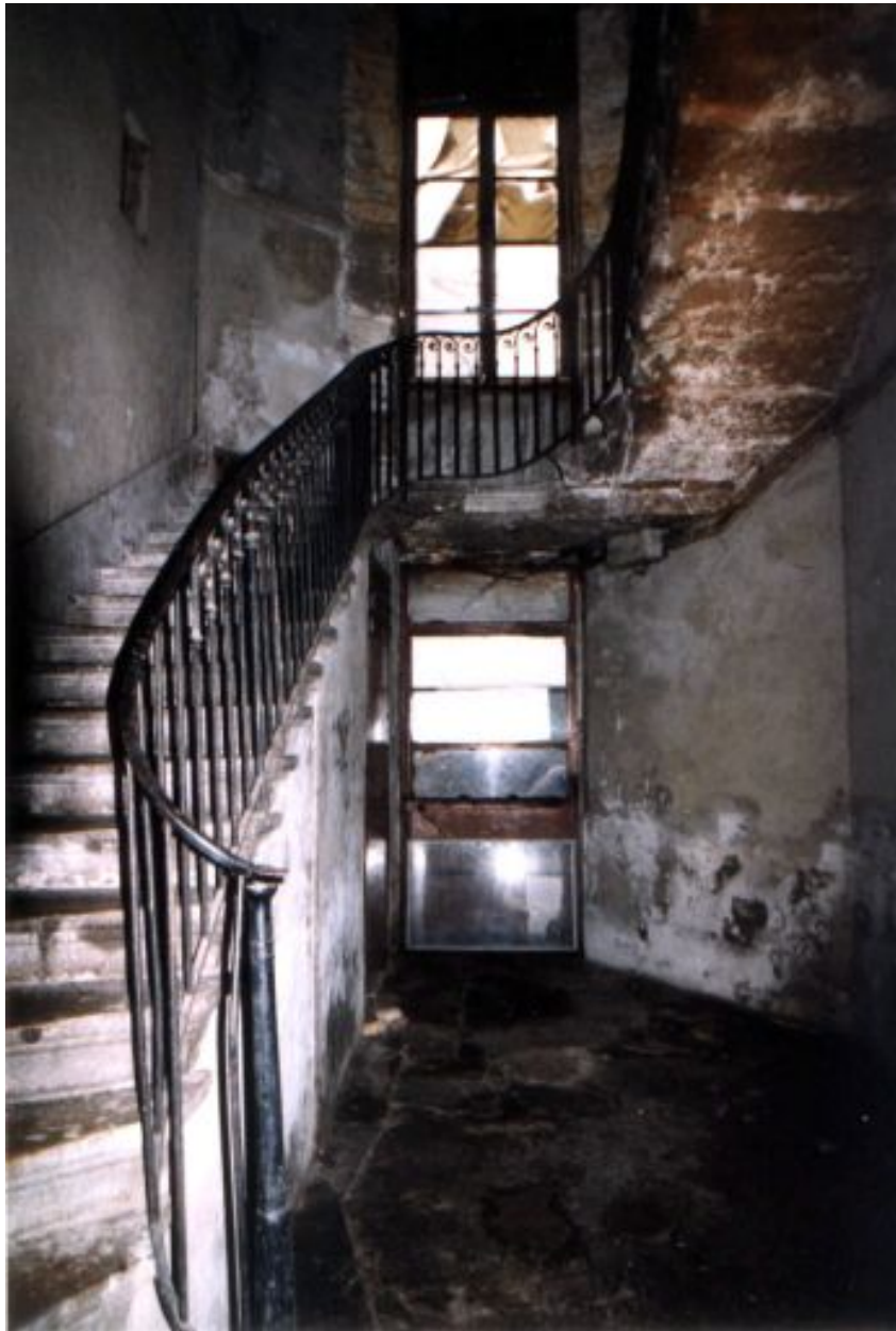
Vue d'ensemble de l'escalier
