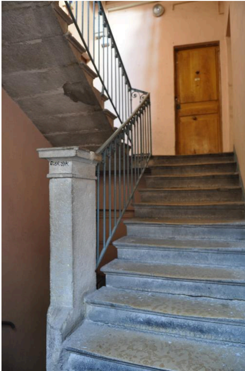
Vue intérieure : escalier, pilier en pierre
