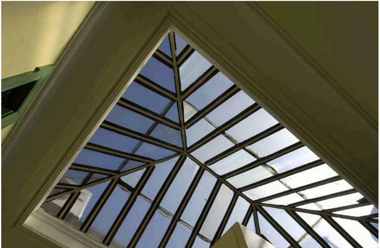
Cage d'escalier : éclairage zénithal ou "ciel ouvert"
