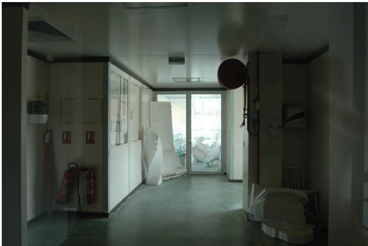
Vue d'ensemble des espaces de circulation
