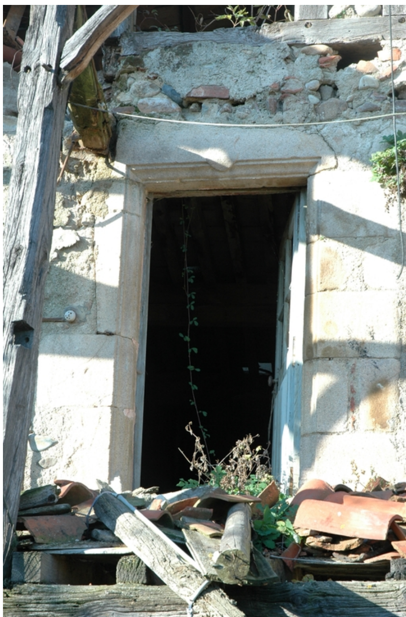
Détail de la porte centrale du 1er étage.
