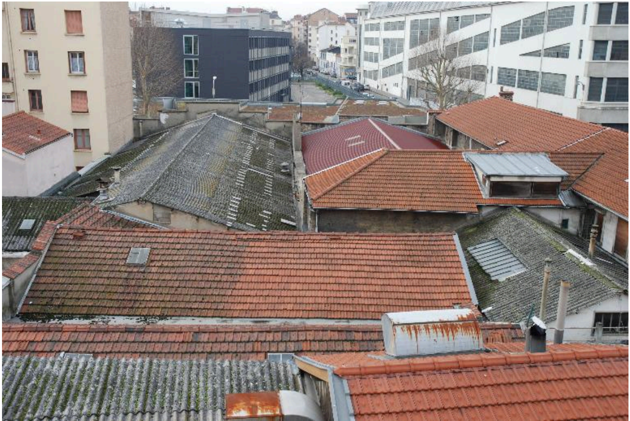
Ilot dit Mazagran 2, vue des ateliers situés en coeur d'îlot, depuis le 4 rue Jangot.
