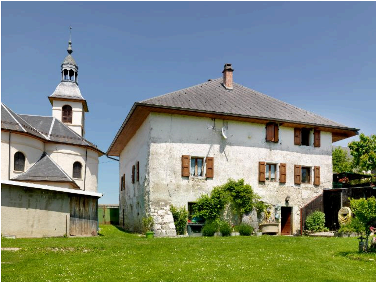
Vue générale du pesbytère.
