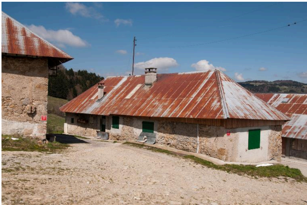
Salle de fabrication, freidi et actuelle habitation, vue depuis le sud-ouest.
