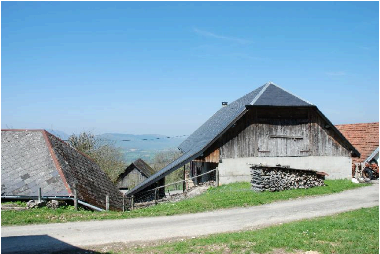
Vue de la partie aval : accès au fenil.
