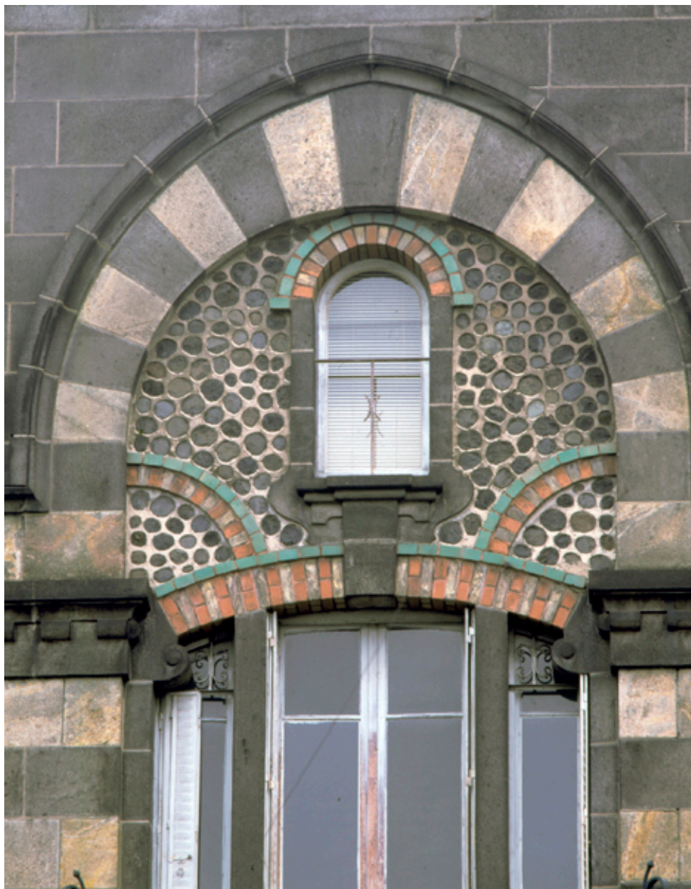
Baie de travée d'angle de l'immeuble, dit villa Giraudon, 27 avenue d'Italie
